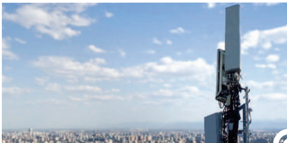
Les antennes 5G améliorent la robustesse du signal mais se situent à très hautes fréquences, premières sacrifiées par les intempéries (source : Huawei)
